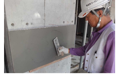
タイル下地モルタル塗布
