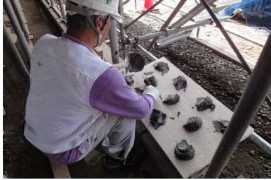
断熱材GL貼り
