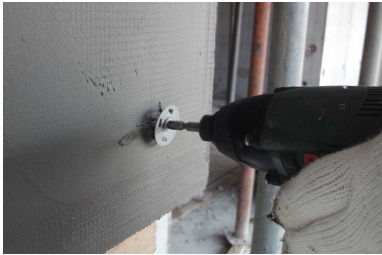
コンクリートビス&ワッシャー留付け
