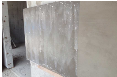
プライマー塗布
